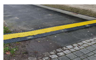
Canaline per cavi
