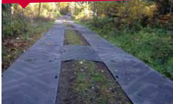
les routes d'accès
