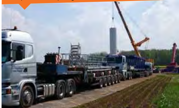
superficie base para grúa
