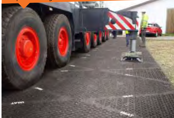
superficies de grúas
