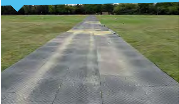
logistyka - tymczasowa droga dojazdowa
