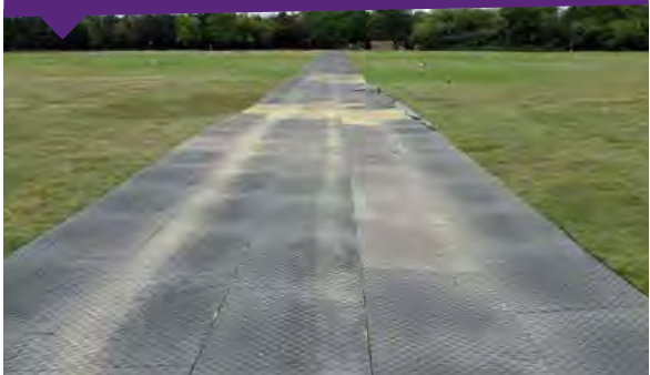
logistică - drum de acces temporar
