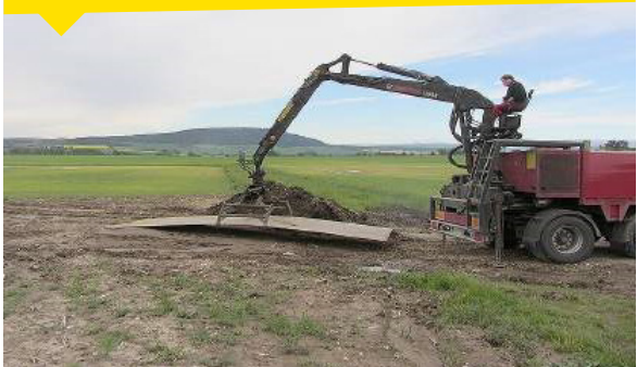
Verlegung erfolgt direkt vom LKW
