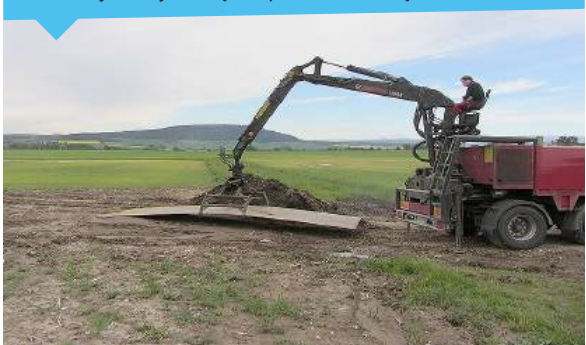
instalacja odbywa się bezpośrednio z ciężarówki
