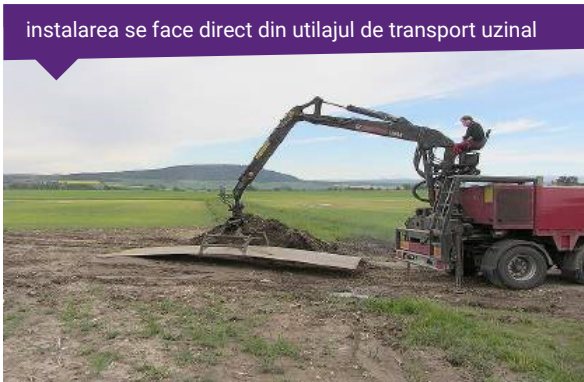
extinderea rutelor pentru încărcăturile grele
