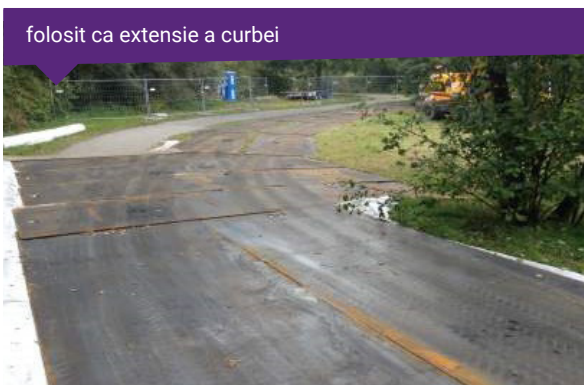
instalarea se face direct din utilajul de transport uzinal
