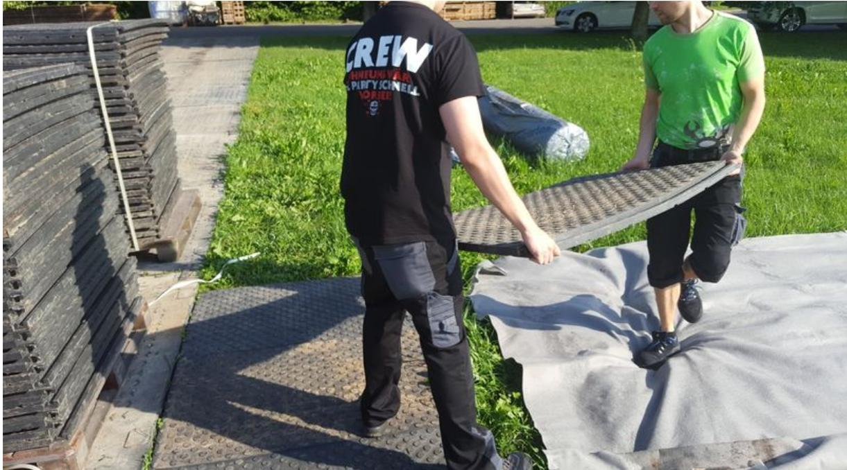
Um die Panels zu verbinden, einfach die Panelränder bzw. Seiten zusammenfügen (Nut und Feder System) und zu einer Fläche verbinden.
